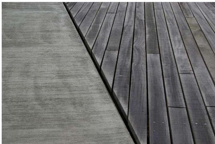
Figur 5 In-situ støbt beton og træbelægning.
