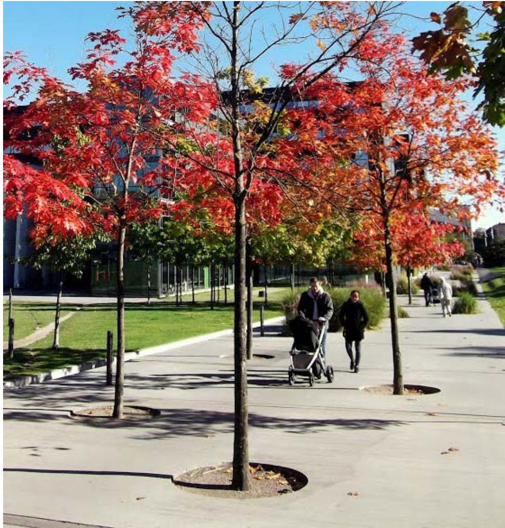
Figur 7 Der skæres huller i overfladebelægningen til beplantning og træer. På fotoet ses et eksempel med skårne huller i betonoverflader fra Frederiksberg Bymidte. Projekt af SLA.
