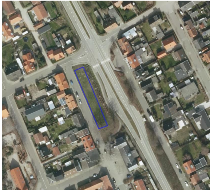
Figur 7 - Parkeringsplads ved Søndergade
