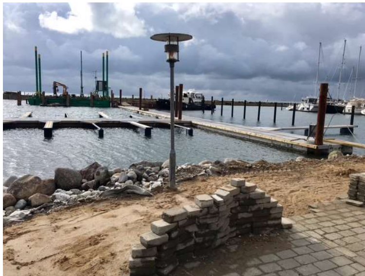
Flydebroer og belægningsarbejde
